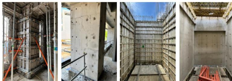
(柱-模板組立情形) (柱-拆模後情形) (電梯-模板組立情形) (電梯-拆模後情形)
