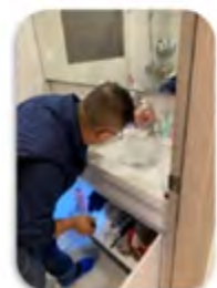
衛浴設備檢查
