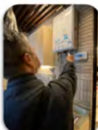
瓦斯洩漏檢查
