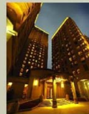
2004 福和橋畔 / 昇陽麗典 2003年中華建築金石獎 規劃設計類 2004年綠建築獎 2004年中華建築金石獎 - 施工品質類白金首飾
