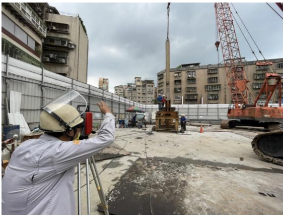
逆打鋼柱校正
