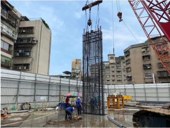
鋼筋籠吊放
