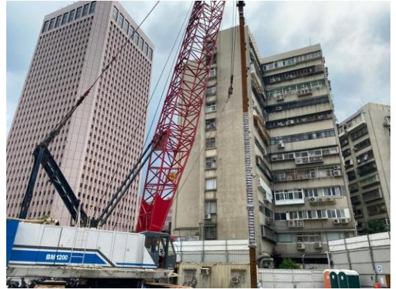
逆打鋼柱吊放
