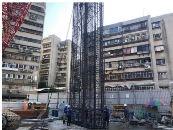
鋼筋籠吊放
