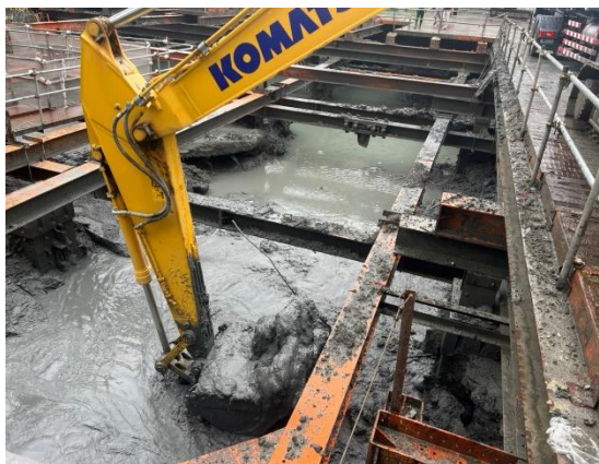
第二層土方開挖施作
