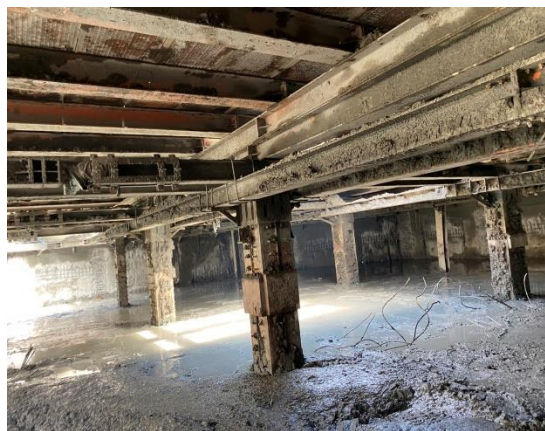
第二層土方開挖完成
