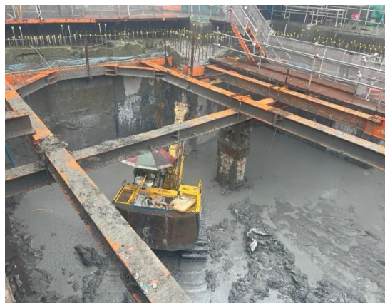
第二層土方開挖施作
