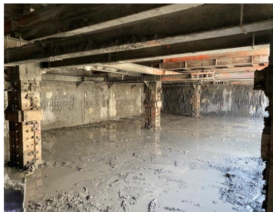
第二層土方開挖完成
