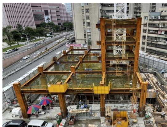
鋼構第一節完成
