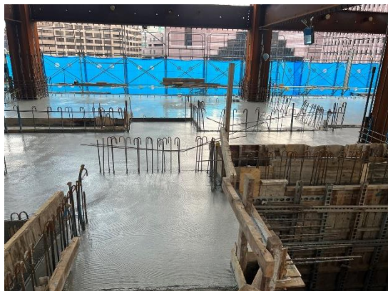
混凝土搗築完成
