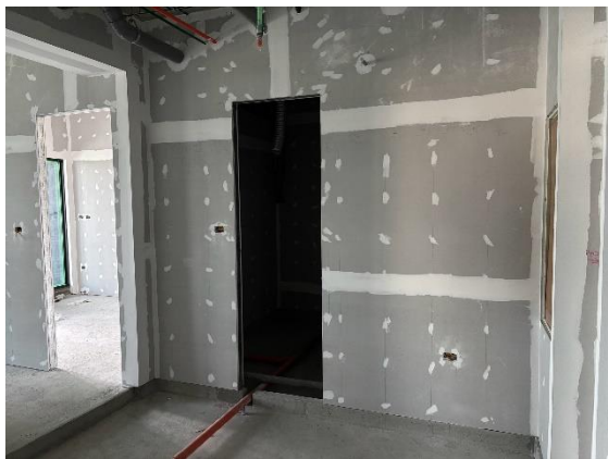
室內輕隔間施作
