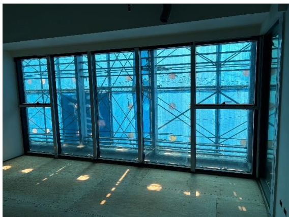
外牆鋁窗安裝
