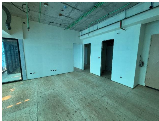
室內高架地板施作
