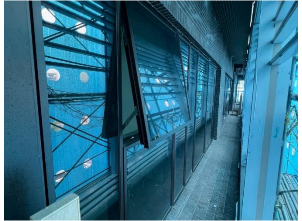
外牆磁磚及金屬隔柵施作
