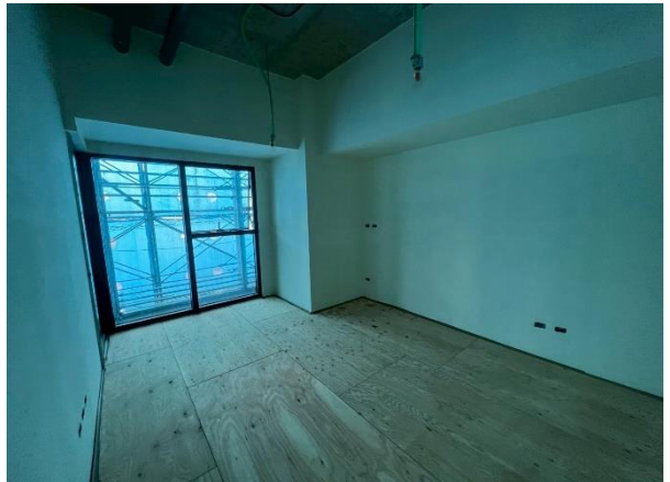
室內高架地板施作
