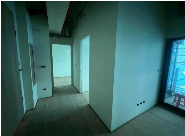
室內輕隔間施作
