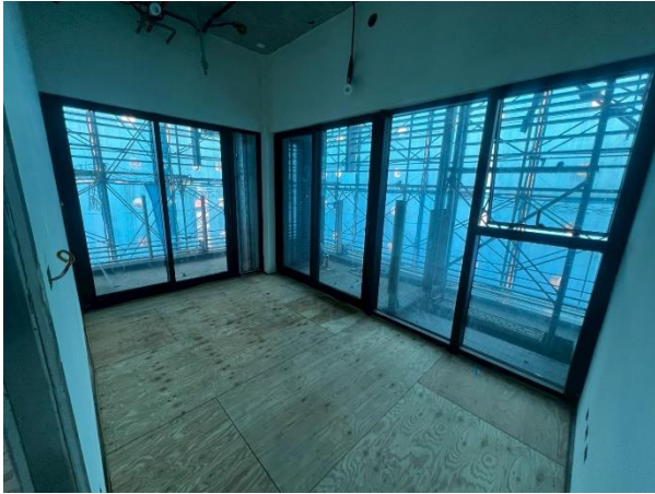
外牆鋁窗安裝
