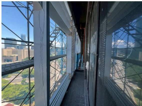
金屬隔柵施作
