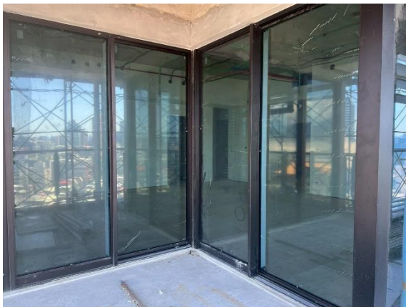
外牆鋁窗及磁磚安裝
