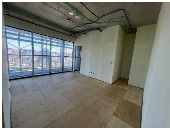
室內高架地板施作
