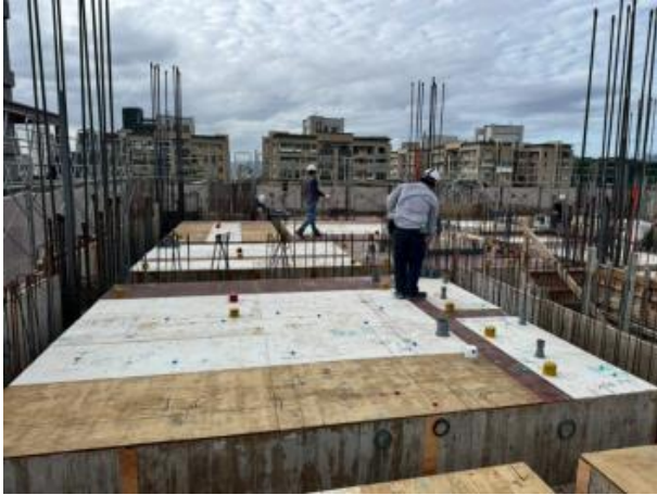
9FL模板鋪設
