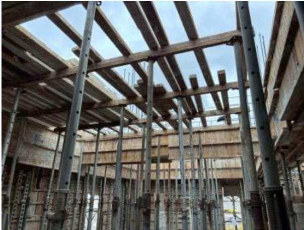
12FL模板鋪設
