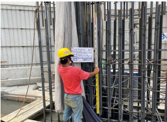
鋼筋搭接長度查驗
