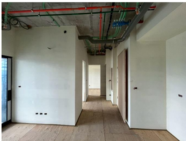
室內輕隔間施作
