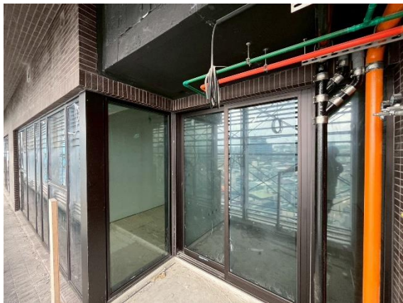
外牆鋁窗及磁磚安裝
