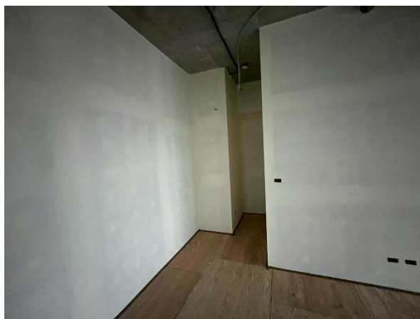
室內輕隔間施作
