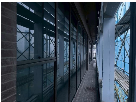
外牆鋁窗及磁磚安裝
