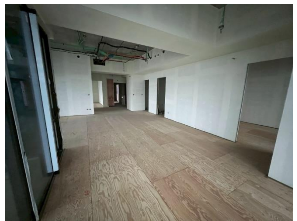
室內高架地板施作
