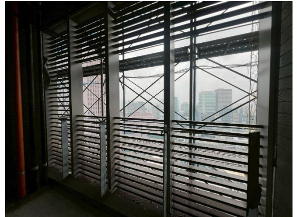
金屬隔柵施作
