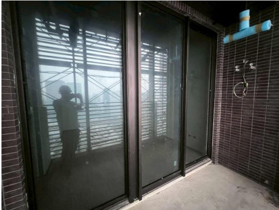
外牆鋁窗及磁磚安裝
